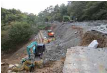
[사진 3-11] 태풍피해로 무너진 도로 및 제방 응급복구
